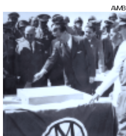
Início das obras de instalação da siderúrgica
